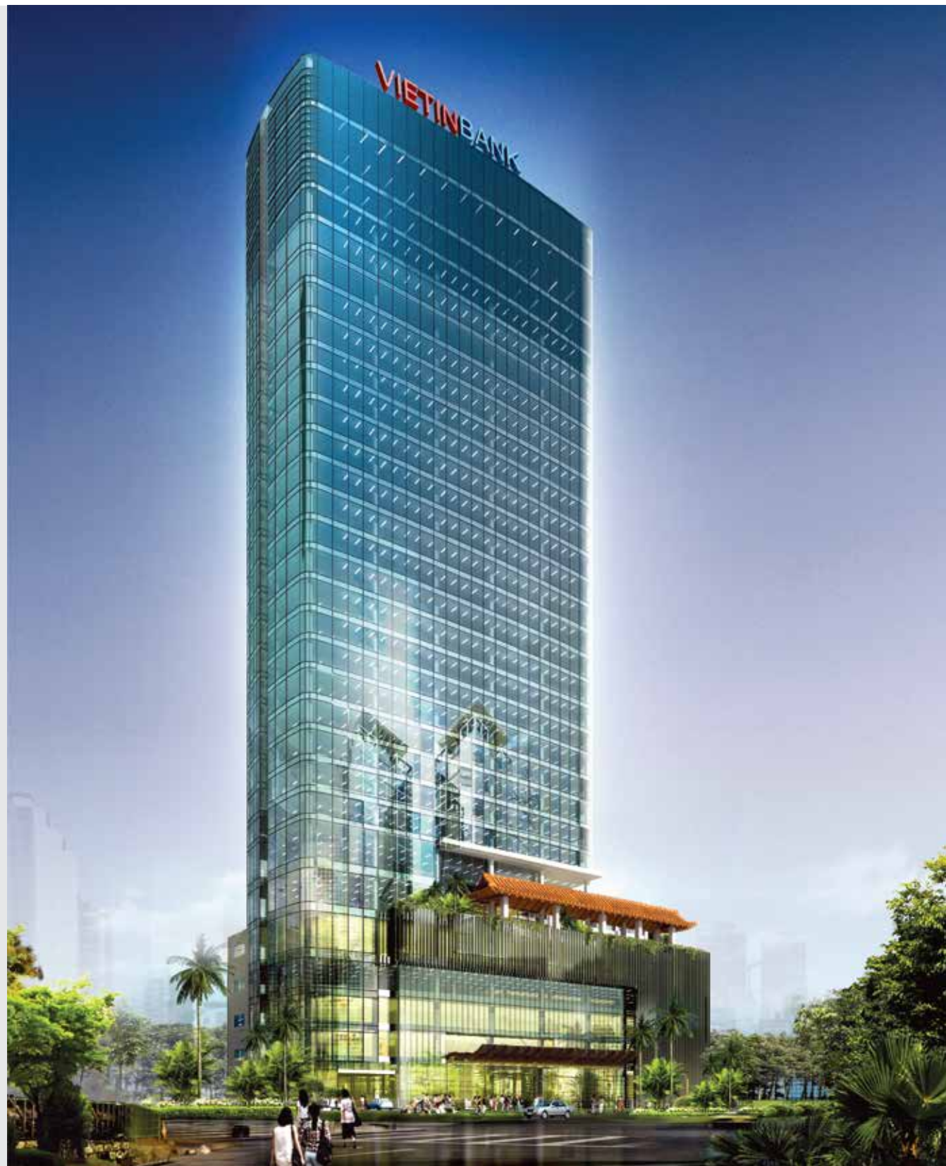
VĂN PHÒNG LÀM VIỆC KẾT HỢP DỊCH VỤ CAO CẤP VIETINBANK HUẾ Chủ đầu tư: Ngân hàng TMCP công thương Việt Nam/ Loại hình: VP kết hợp khách sạn/ Địa điểm: số 02 Lê Quý Đôn, TP.Huế/ Chiều cao: 30 tầng/ Tổng diện tích sàn: 39,000m 2 / Tổng mức đầu tư: 830 tỷ VNĐ/ Thời gian thực hiện: 2011/ Công việc công ty đảm nhiệm: Kết hợp với công ty Line Architect ( Hàn Quốc), Thiết kế cơ sở, TKT, BVTC và Tổng dự toán
