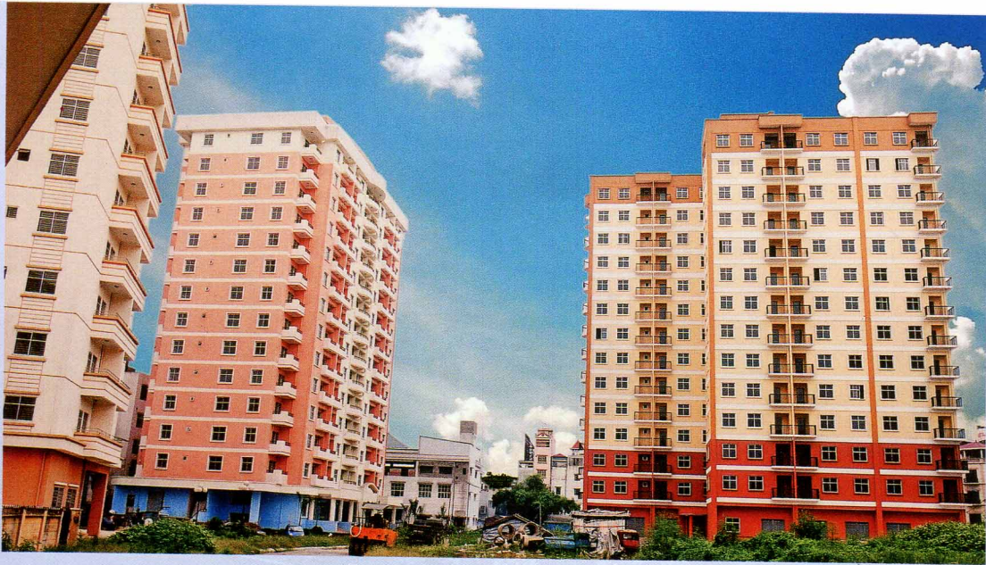
Khu nhà ở cao tầng di dân quận Cầu Giấy nhà N05 và N06
