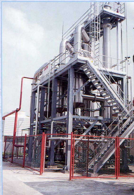
Nhà máy nước hoa quả cô đặc Kiên Giang
